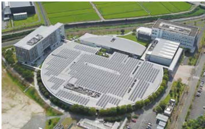
円形の屋根が太陽光パネルで覆われた1号館校舎
