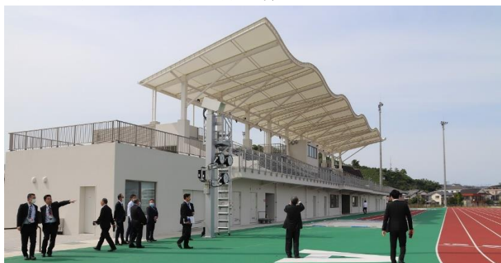
7月に供用開始される 天草市陸上競技場
