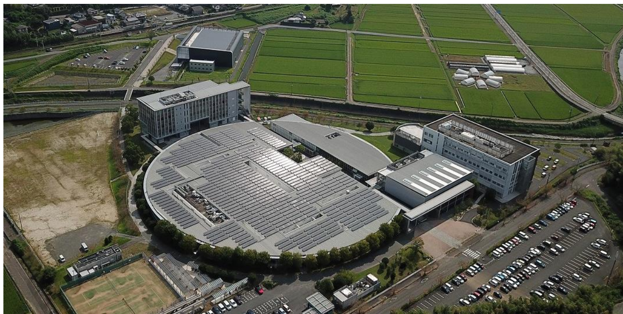
円形の1号館屋根根に設置された太陽光パネル
