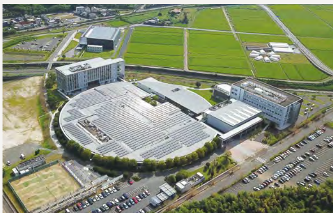
円形の1号館屋根に設置された太陽光パネル
