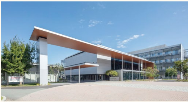
新レストラン正面にフロントゲートを設置
